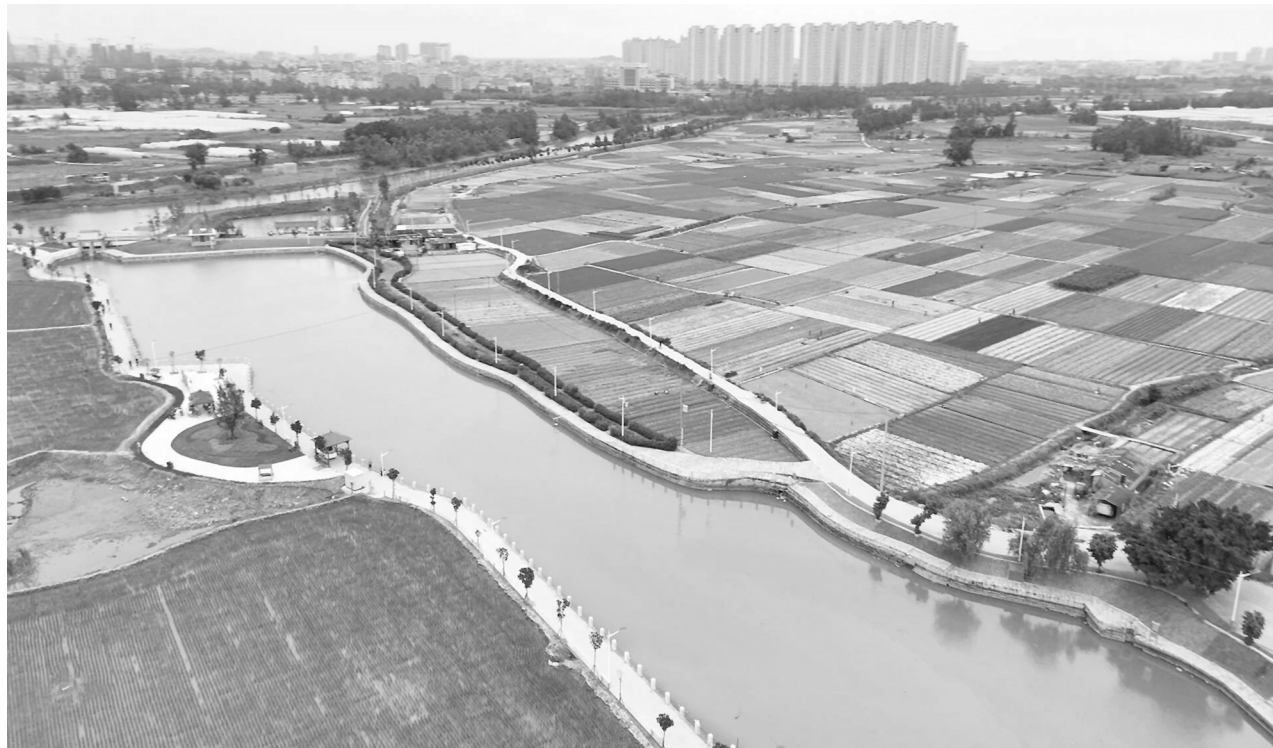
通过综合整治,大盈溪不仅疏通了脉络、加固了岸线,还修建起生态护岸与休闲步道。
