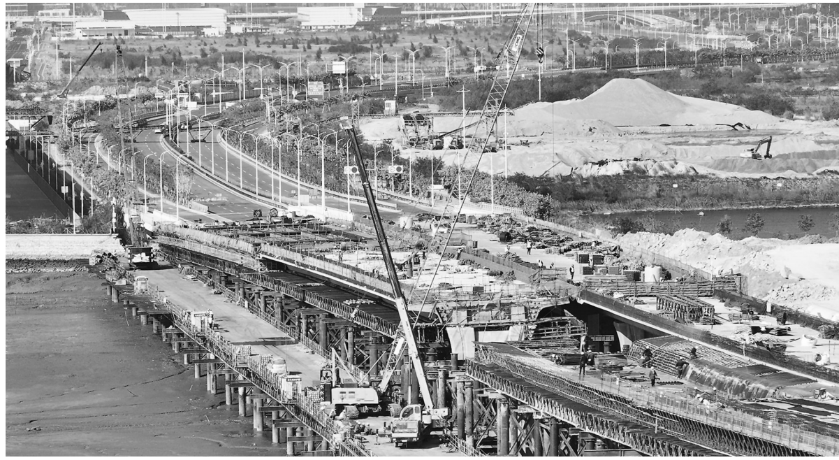
正在进行上部结构现浇箱梁施工。滨海大道翔安连接线的桥梁下部结构已经全部完成。
