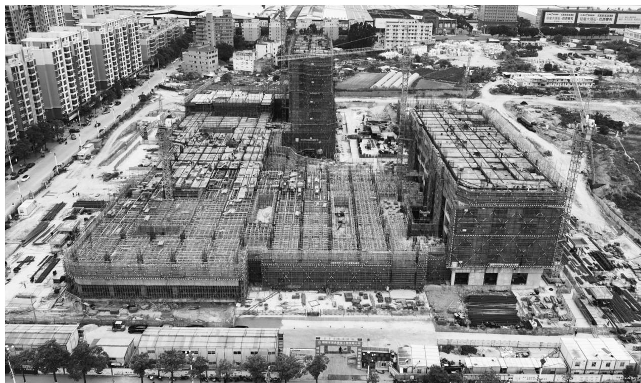
项目预计春节前可实现教学综合楼主体结构封顶。
