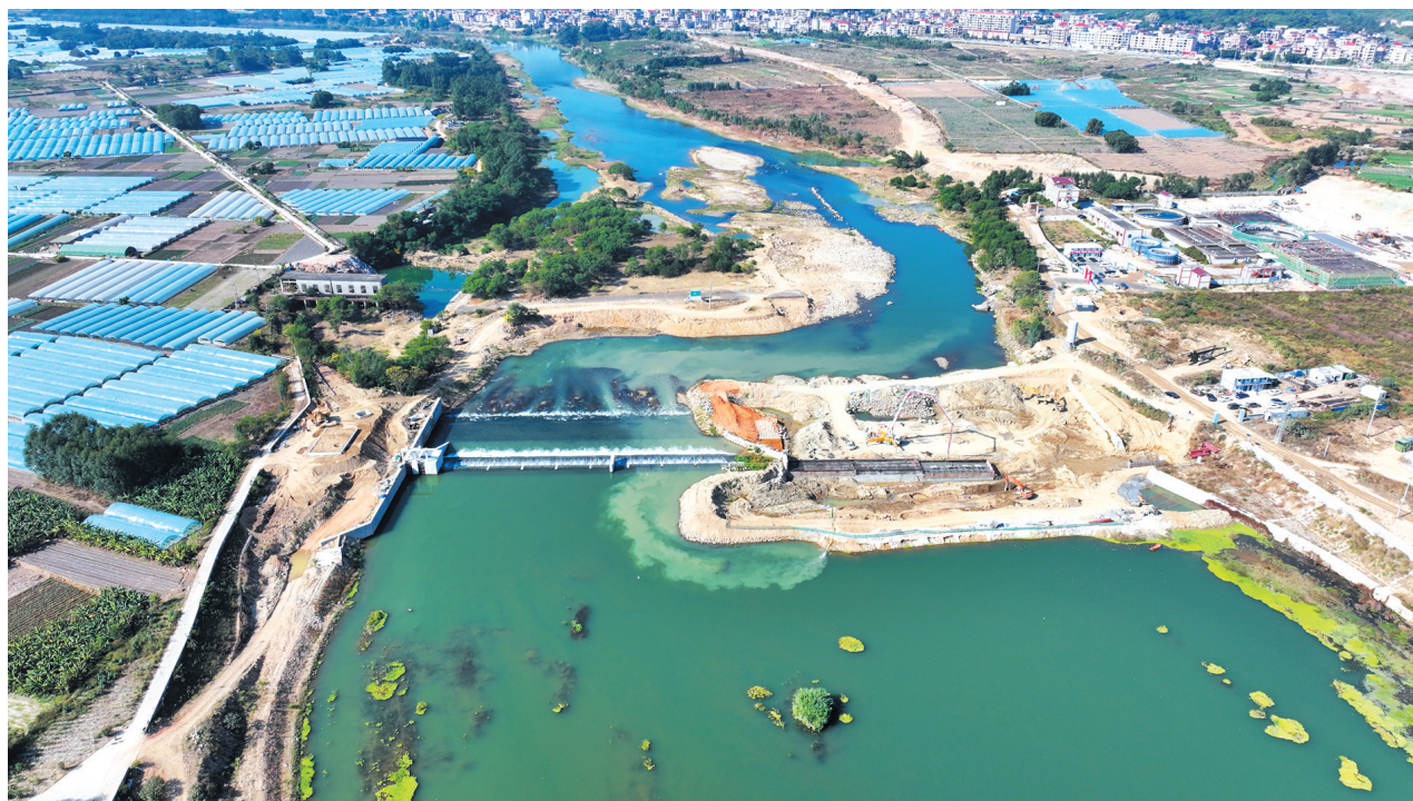
施工中的山美灌区洪濂灌片气盾坝项目
