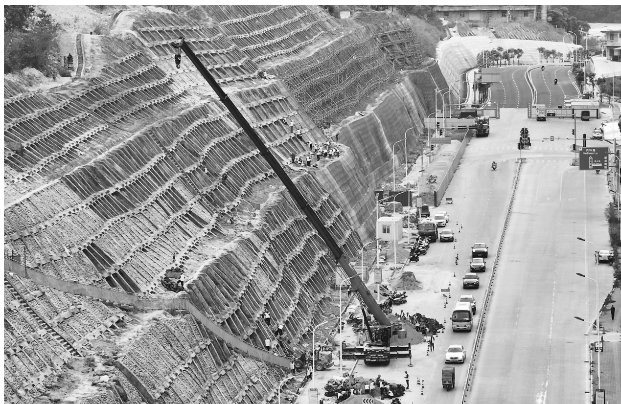
南安市外二环路边坡改造工程现场
