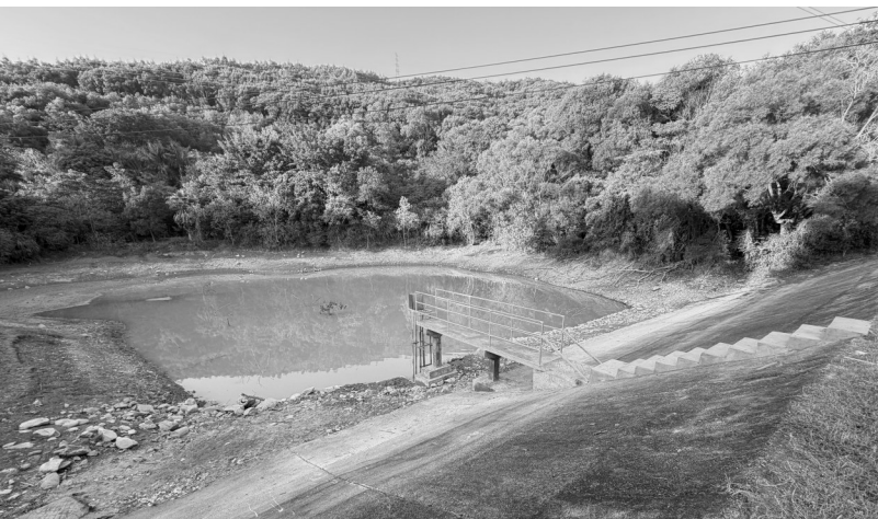
完成除险加固的下包丘山塘
