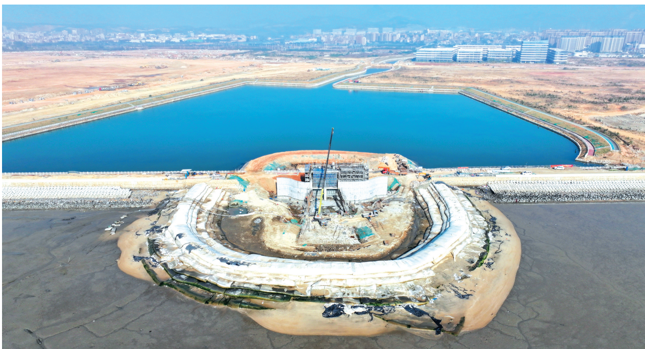
新建水闸兼具排涝、挡潮、纳潮等综合功能。
