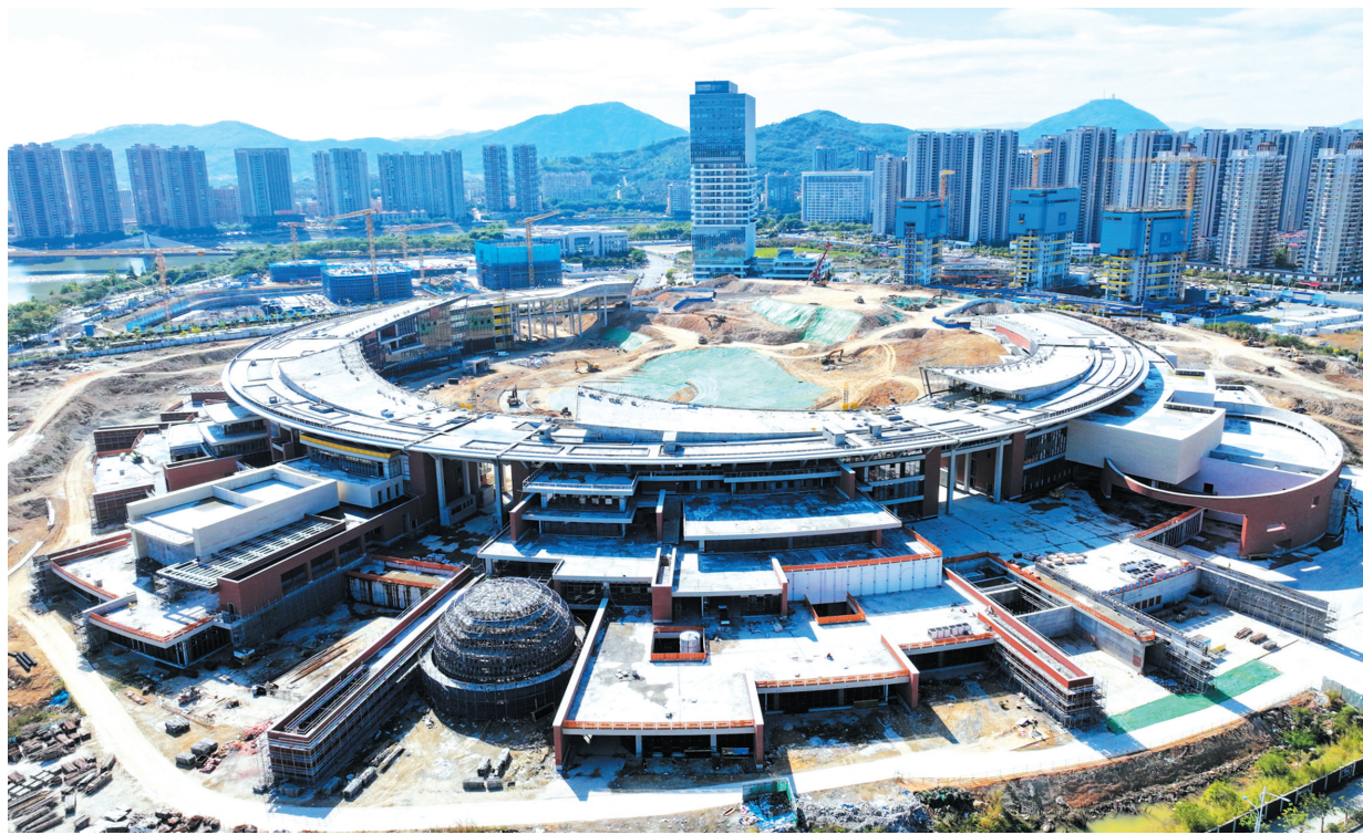
建设中的五馆,部分区域已开始进行外墙装修。
