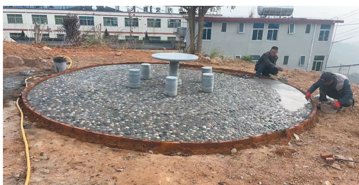
工人正在施工中。
