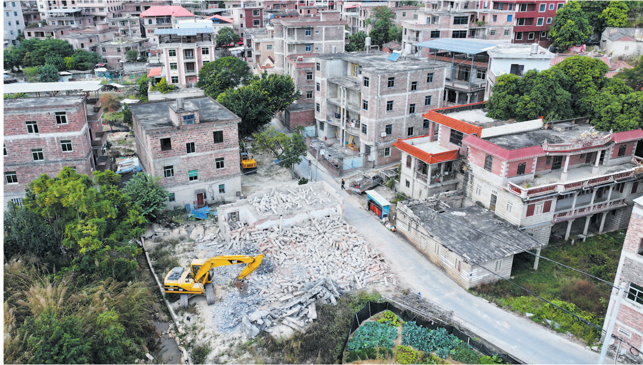
挖掘机对房屋进行拆除。
