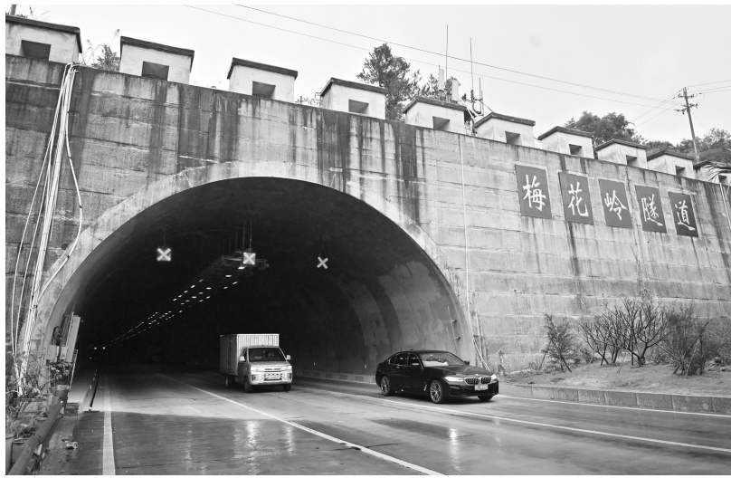
梅花岭隧道内日常车流量较大，却存在灯光照度不足、光线分布不均等问题。
