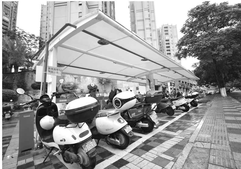
中节能小区安装喷淋装置，提升居民的安全感。
