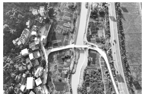
兰溪山洪沟治理项目已进入收尾阶段。
