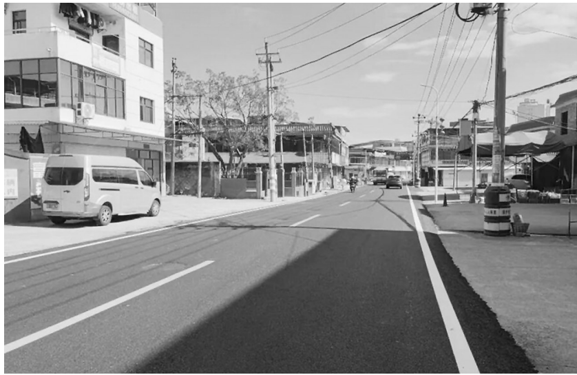
改造后的道路,通行更便捷安全,视觉观感也大幅提升。
