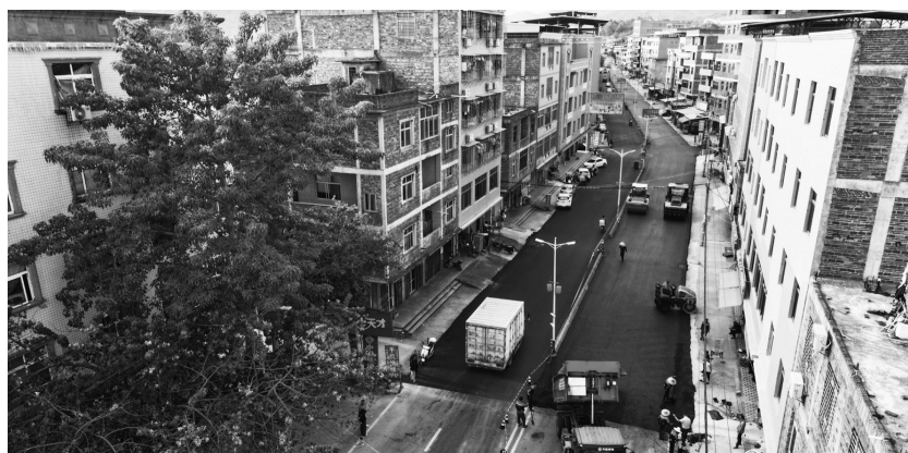
溪北公路溪州村段完成“白改黑”改造。
