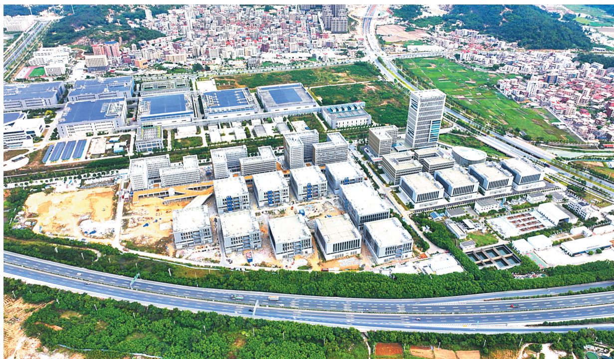
南安科创中心项目二期已全面进入内外装饰装修及水电安装阶段。
