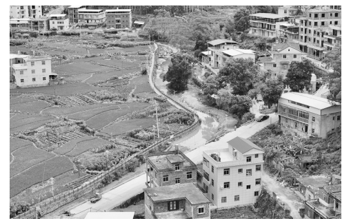
飞云村新建的堤岸已基本完工。
