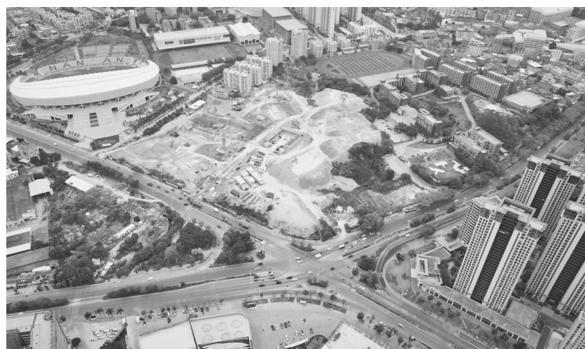
体育中心片区更新改造如火如荼。图为源昌凤鸣居项目施工现场。
