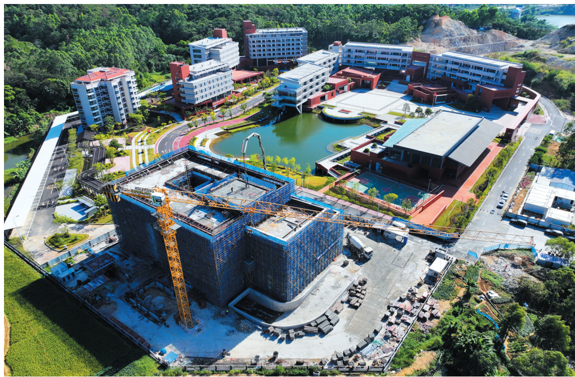
南安市委党校(二期)主体结构全面封顶。
