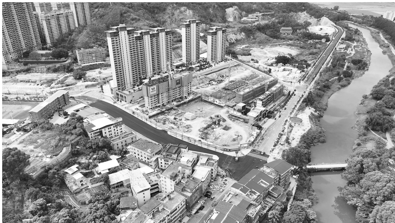
南安市港仔渡片区4条市政道路基本完工。
