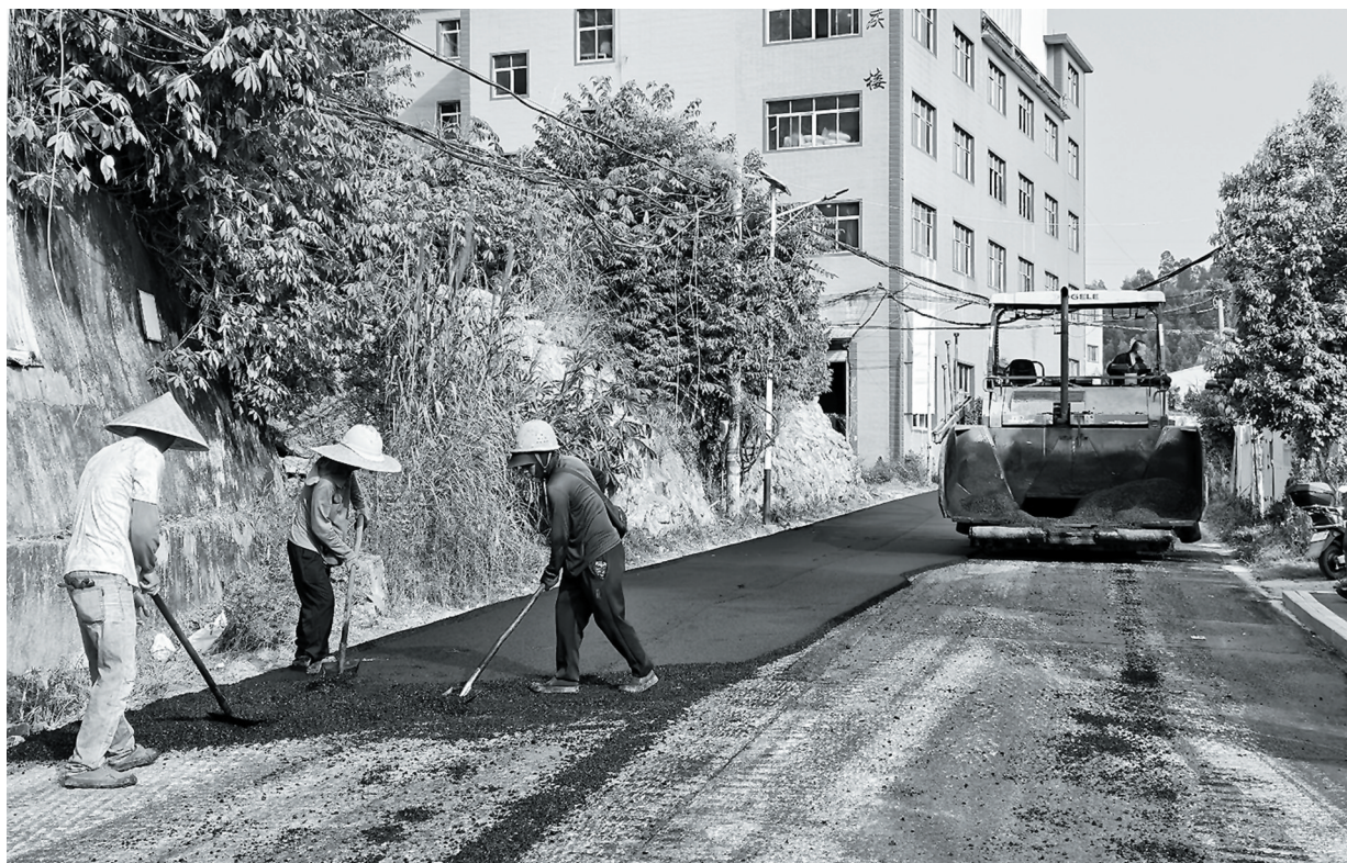
工人们正在铺设沥青。
