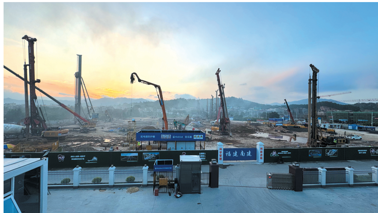
南安市江北水质净化厂已经火热开工。
