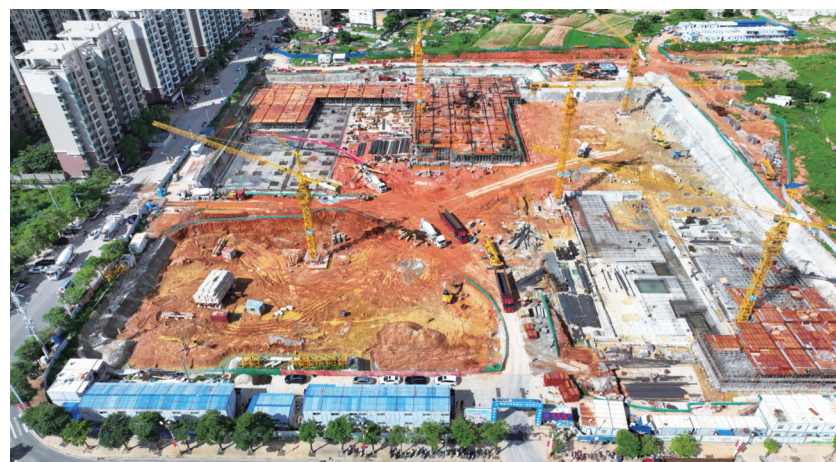
南安市总医院水头分院(南安市海都医院)县域次中心迁建项目正全力推进地下室底板浇筑等基础工序的施工。
