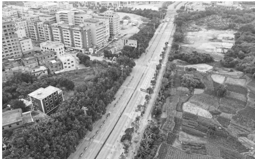
滨江大道改造提升工程(机械光伏产业园段)全长3.217公里。
