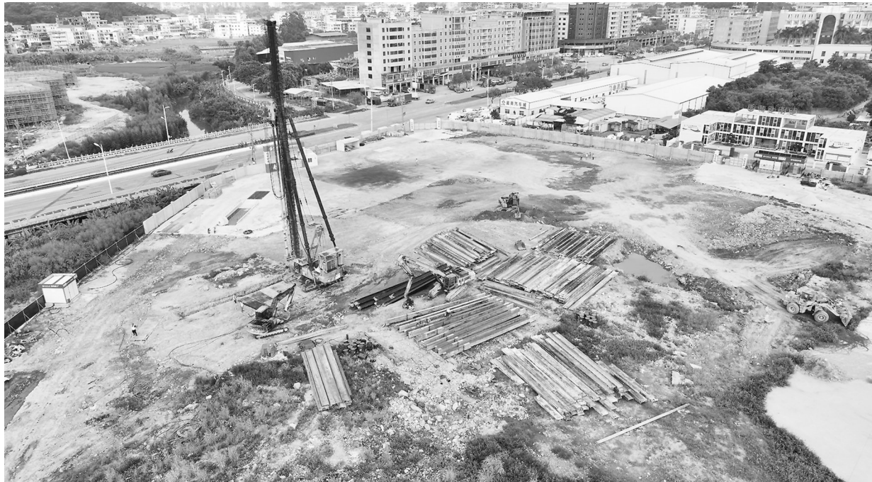
城区污水处理提质增效工程建设现场
