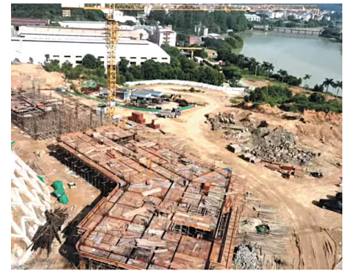
主体结构施工现场
