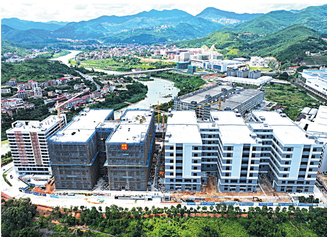
位于南安市仑苍镇的云科高定数字产业园项目建设现场
