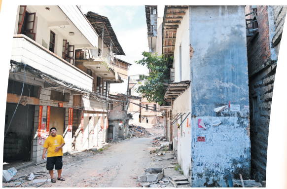
拆迁陆续展开,五柱巷的印象即将碎片化。
