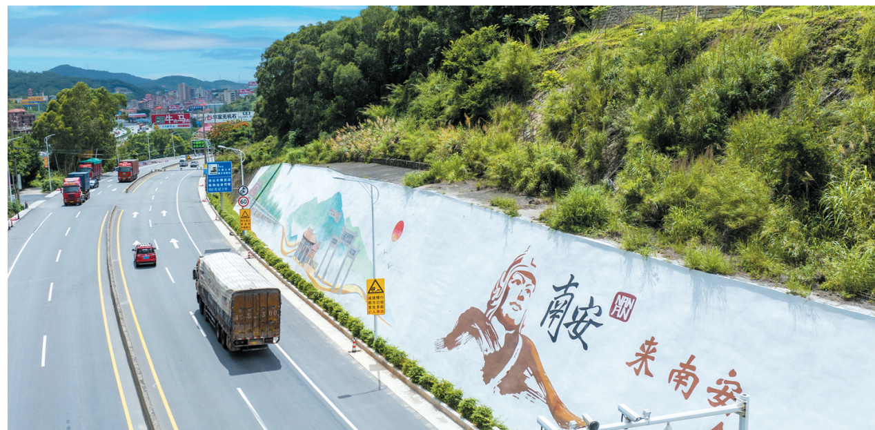
国道 324 线南安水头小盈岭段,路边设有 1200 多平方米的艺术彩绘墙。
