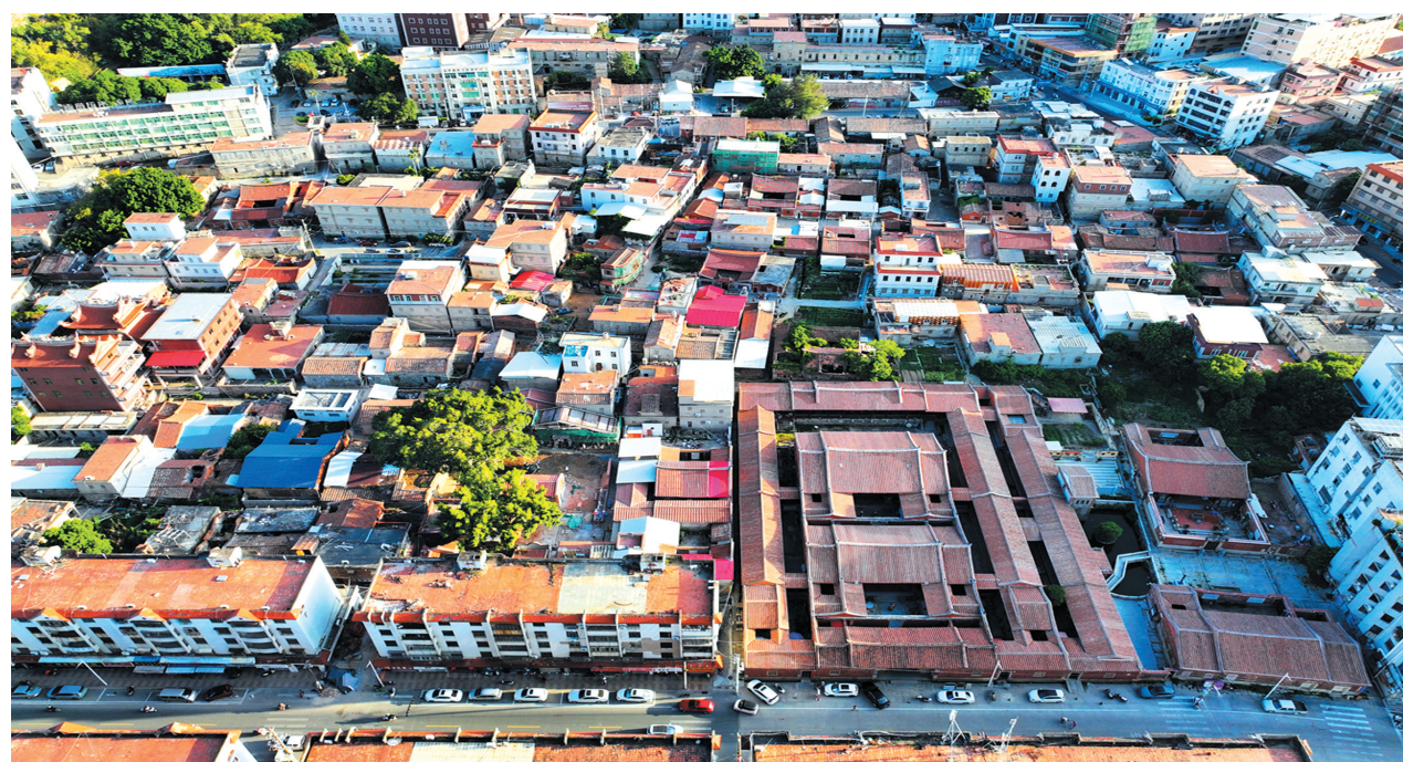
石井镇正在改造的老街，位于中宪第附近。
