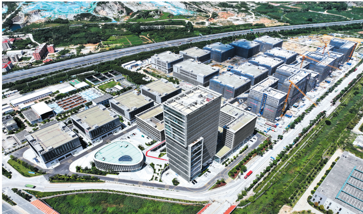
泉州芯谷南安科创中心项目现场
