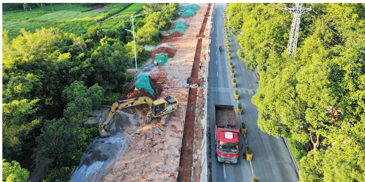
滨江大道泉南高速桥至成辉国际红绿灯路口因地下雨水管道破损严重，泥沙淤积，只能破开路面重铺管道。
