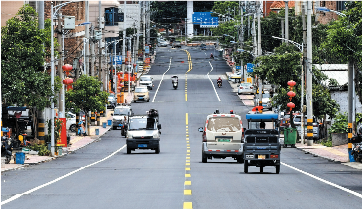
“白改黑”后的沥青路面平整度好，行车噪声小，车辆行驶更加安全、平稳。
