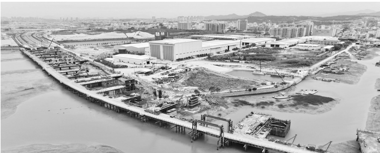
滨海大道翔安连接线工程正在进行钢板桩围堰、承台、墩柱等施工。
