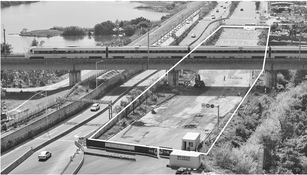
特大桥工程。白框为正在施工的江滨南路(南安段)二期工程下穿杭深线晋江
