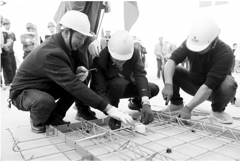
工匠们在老师的指导下，进行钢筋绑扎、固定等操作。
