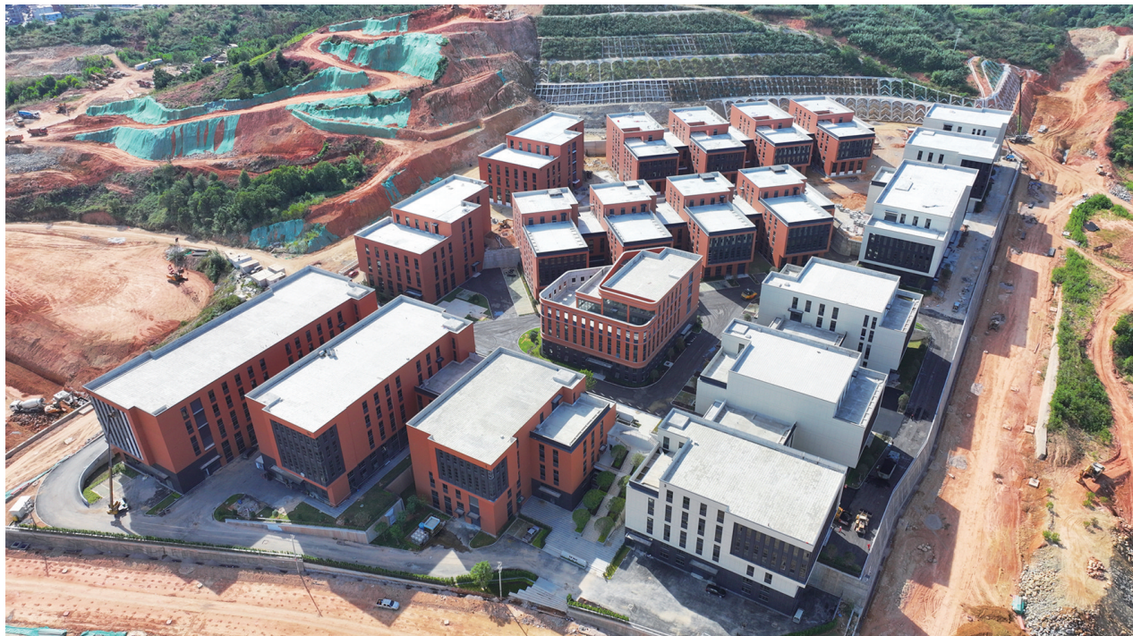
中国(南安)高端阀门智造产业园项目现场
