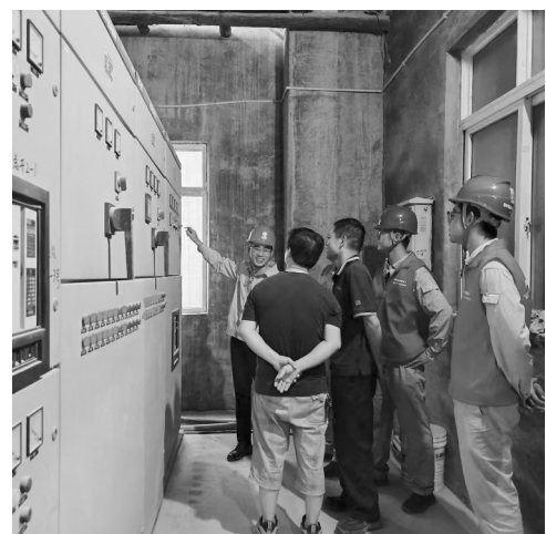
国网南安市供电公司走进南安泰石材有限公司开展电力检查工作。
