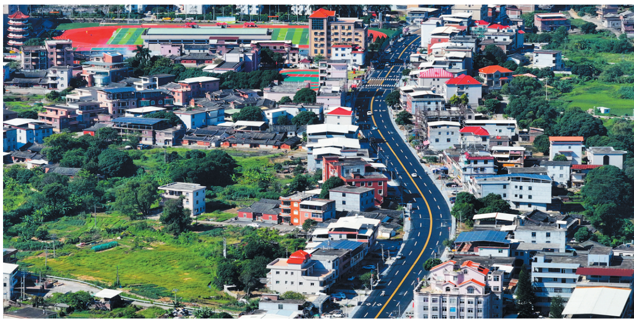
省道215线南安码头镇仙美村至枫树村路面改造工程已基本完工。
