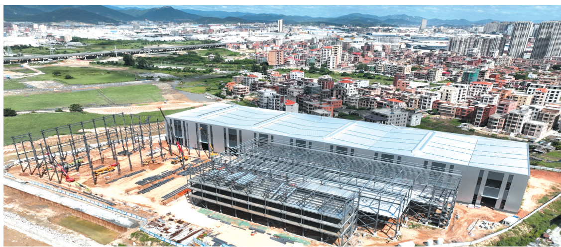
南安国际石材智慧产业园施工现场
