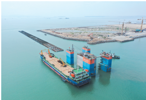
泉州港石井作业区16-17号泊位工程最后一件大型沉箱安装完毕。
