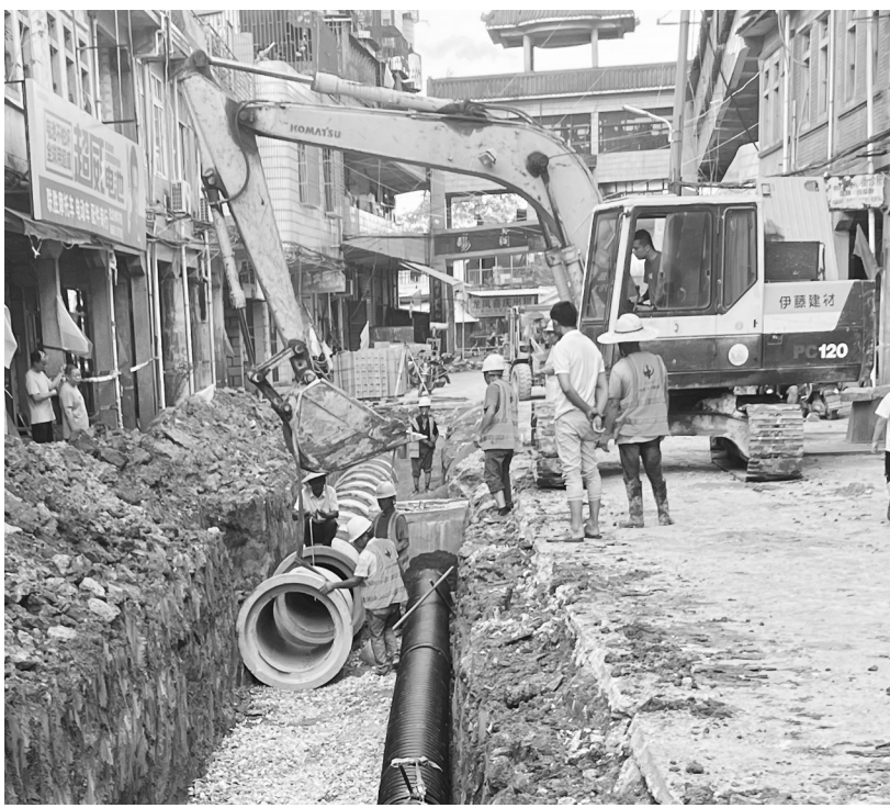
项目施工现场
