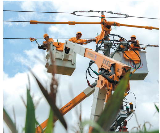
国网南安市供电公司创新开展双履带绝缘斗臂车带电作业。
