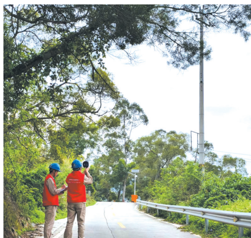
“双满意”党员服务队队员对电力线路进行巡视。
