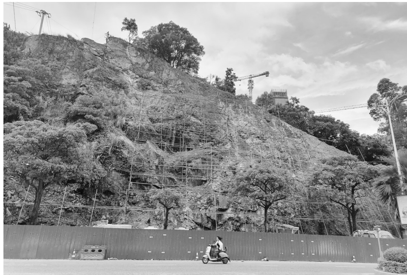
最大的一处山体滑坡正在围挡施工中。
