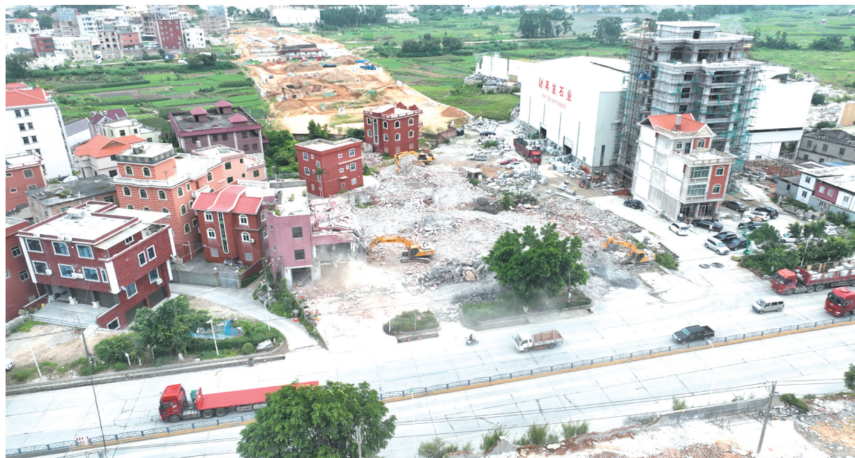
科院北路二期工程水头段拆迁现场
