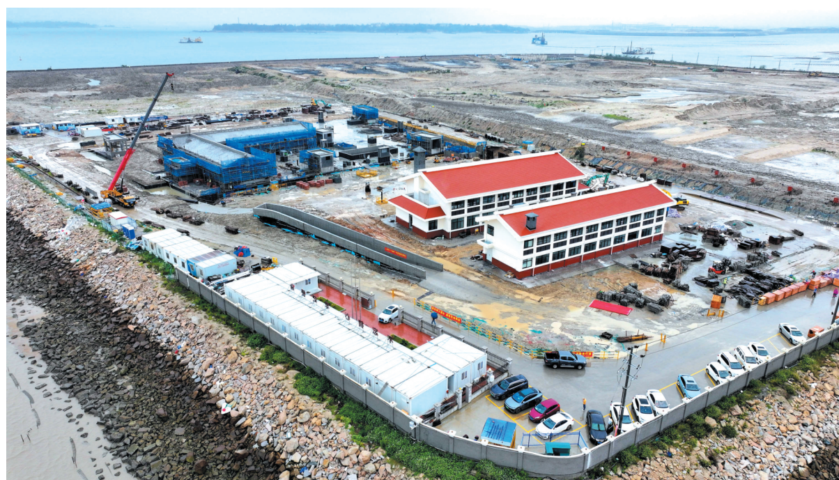
石井镇生活污水处理厂一期工程施工现场
