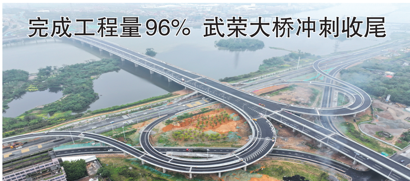
建设中的武荣大桥,横跨晋江,连通霞美、丰州两镇。
