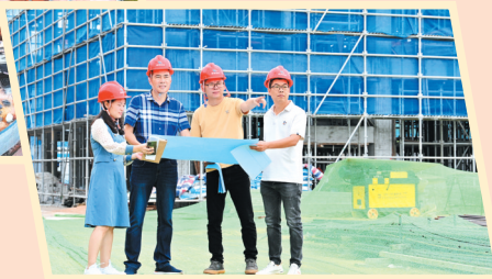
码头镇党委书记黄朝阳在施工现场调研。
