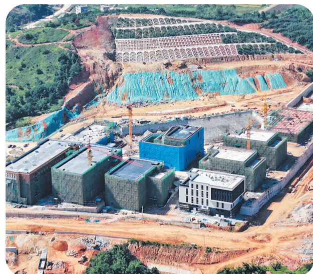
位于英都的中国(南安)高端阀门智造产业园项目。
