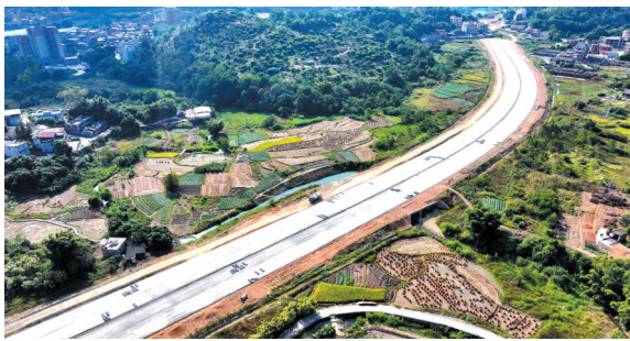
建设中的横八线金淘镇过境段道路工程。
