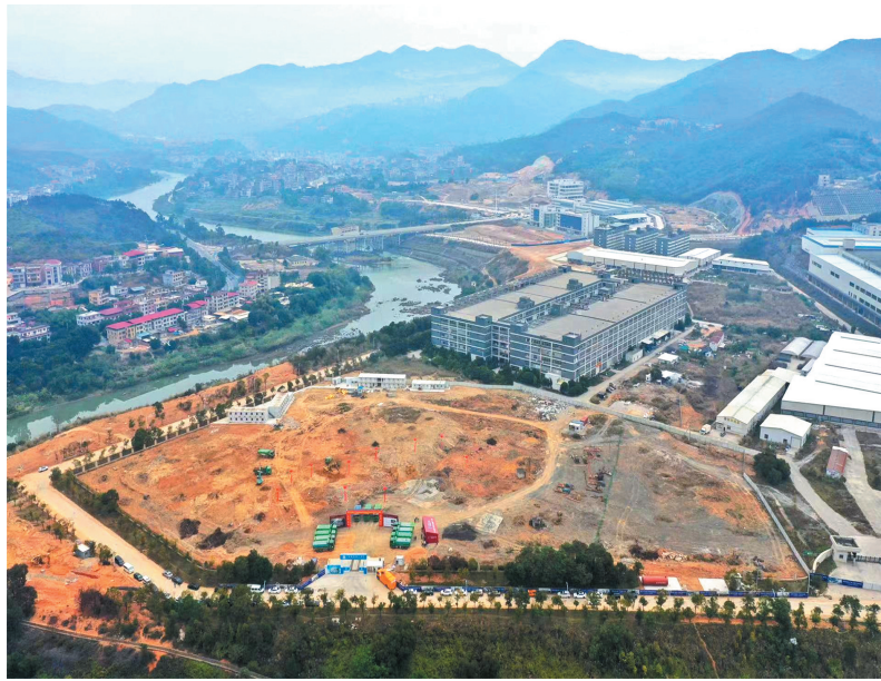
美宇工业园低效用地盘活再开发项目开工现场。
